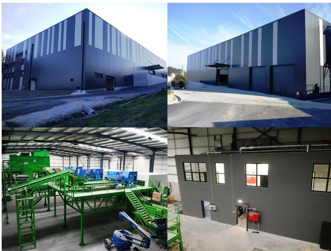
Figura 11 – Imagens da nova Unidade de Triagem de Lustosa
